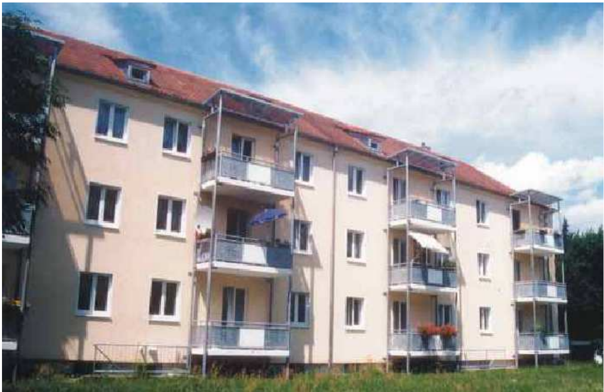
Abb. 12 : Saniertes Wohngebäude „Am Anger“
