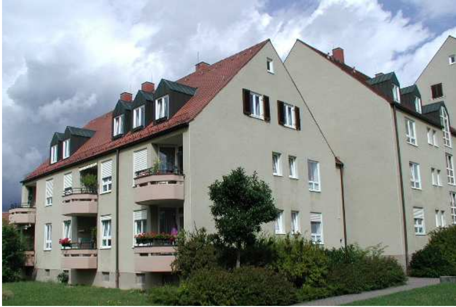
Abb. 3: Wohngebäude in der Rhönstr. (80er Jahre)
