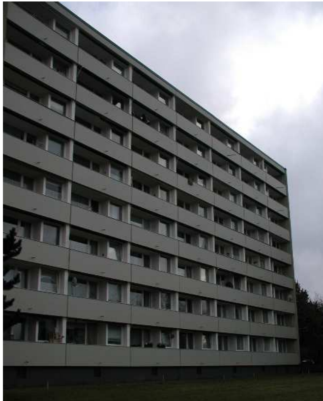
Abb. 4: Wohngebäude aus den 60er Jahren – Tafelbauweise – Ende der 80er Jahre an der Außenfassade mit Wärmeschutz ausgestattet
