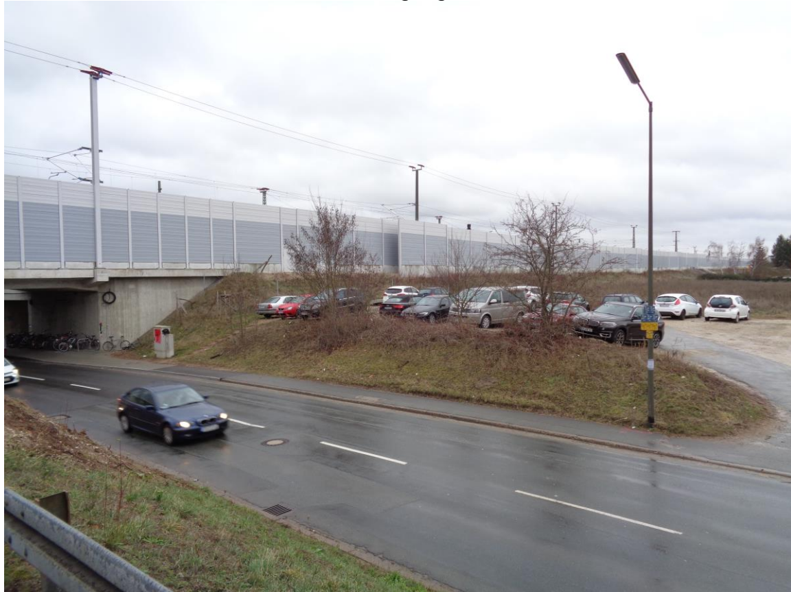
Blick von Norden mit Weinstraße und Zugang S-Bahnhalt Eltersdorf
