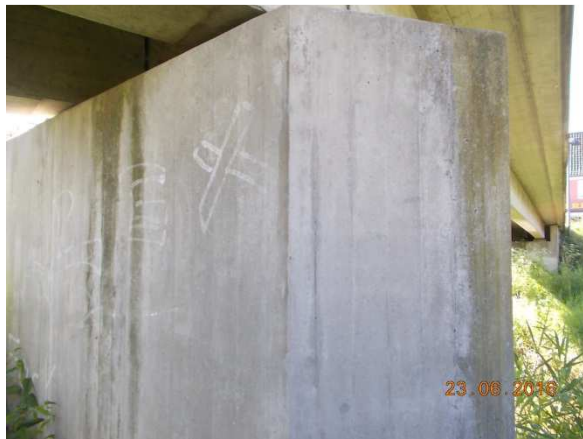
Undichtigkeiten Widerlager und Überbau (Pfeiler) - Betonsanierungen
