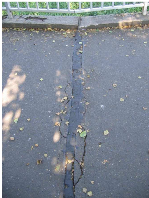
Schäden an Brückenbelag
