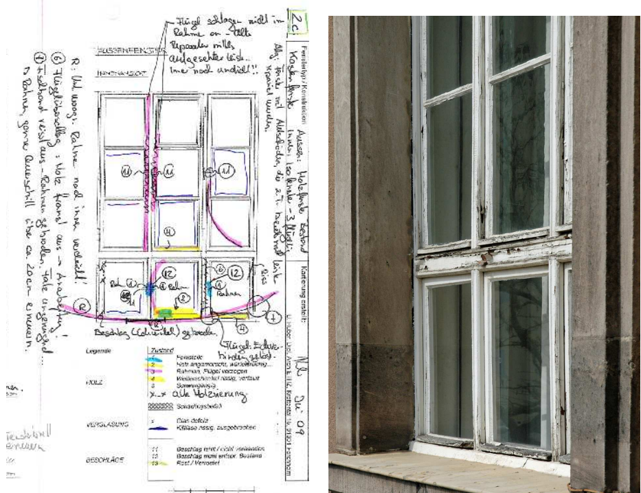
Zeichnerische Schadenskartierung der historischen Fensterelemente durch Restauratoren sowie Außenaufnahme eines Fensterelementes
