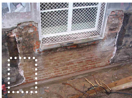
Blankes (d.h. unverputzt) Ziegelmauerwerk sowie fehlende Kehlabdichtung bei Übergang zum Fundamentvorsprung (Kennzeichnung mit rotem Pfeil)
