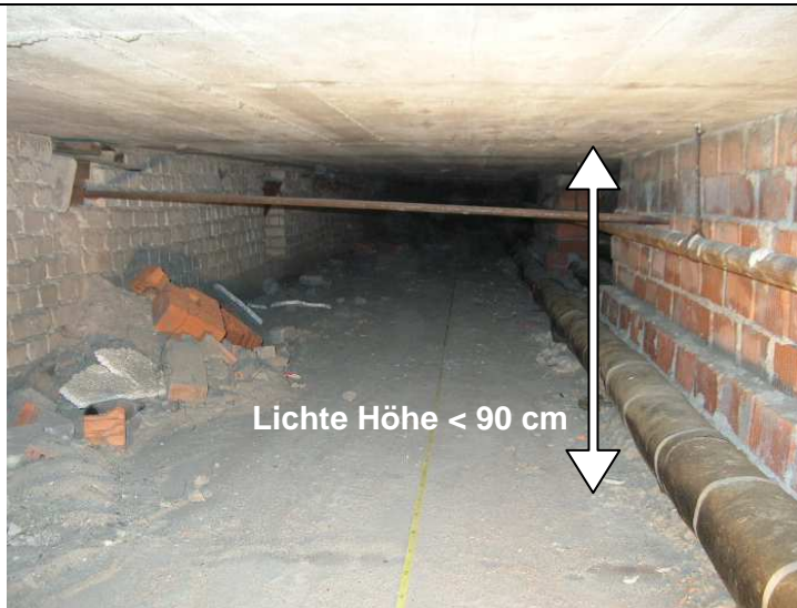
Foto vom Bodenkanal unter Flur des Kellergeschosses
