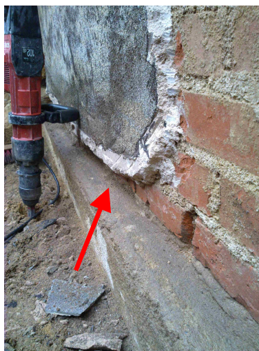
Blankes (d.h. unverputzt) Ziegelmauerwerk sowie fehlende Kehlabdichtung bei Übergang zum Fundamentvorsprung (Kennzeichnung mit rotem Pfeil)
