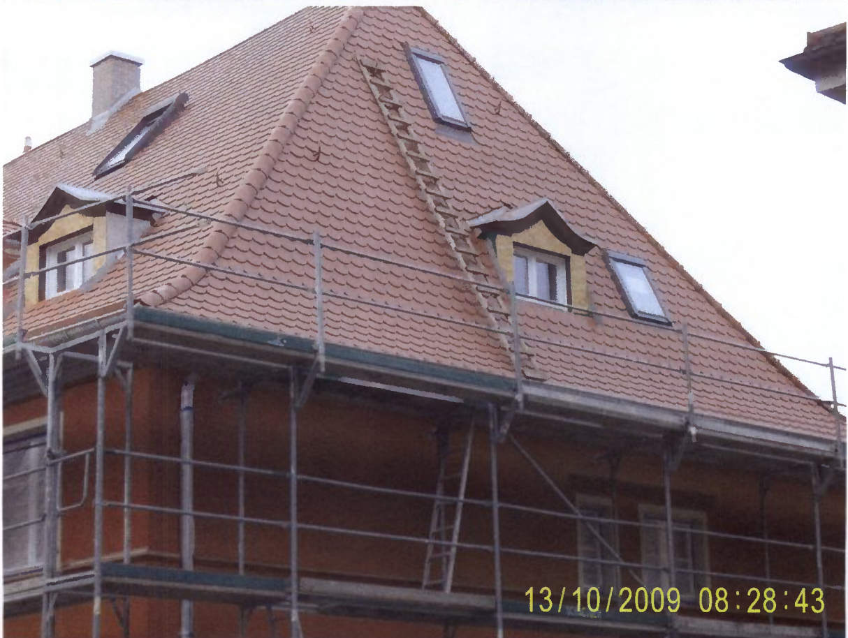
Reinhardstraße 2a, während der Baumaßnahme
