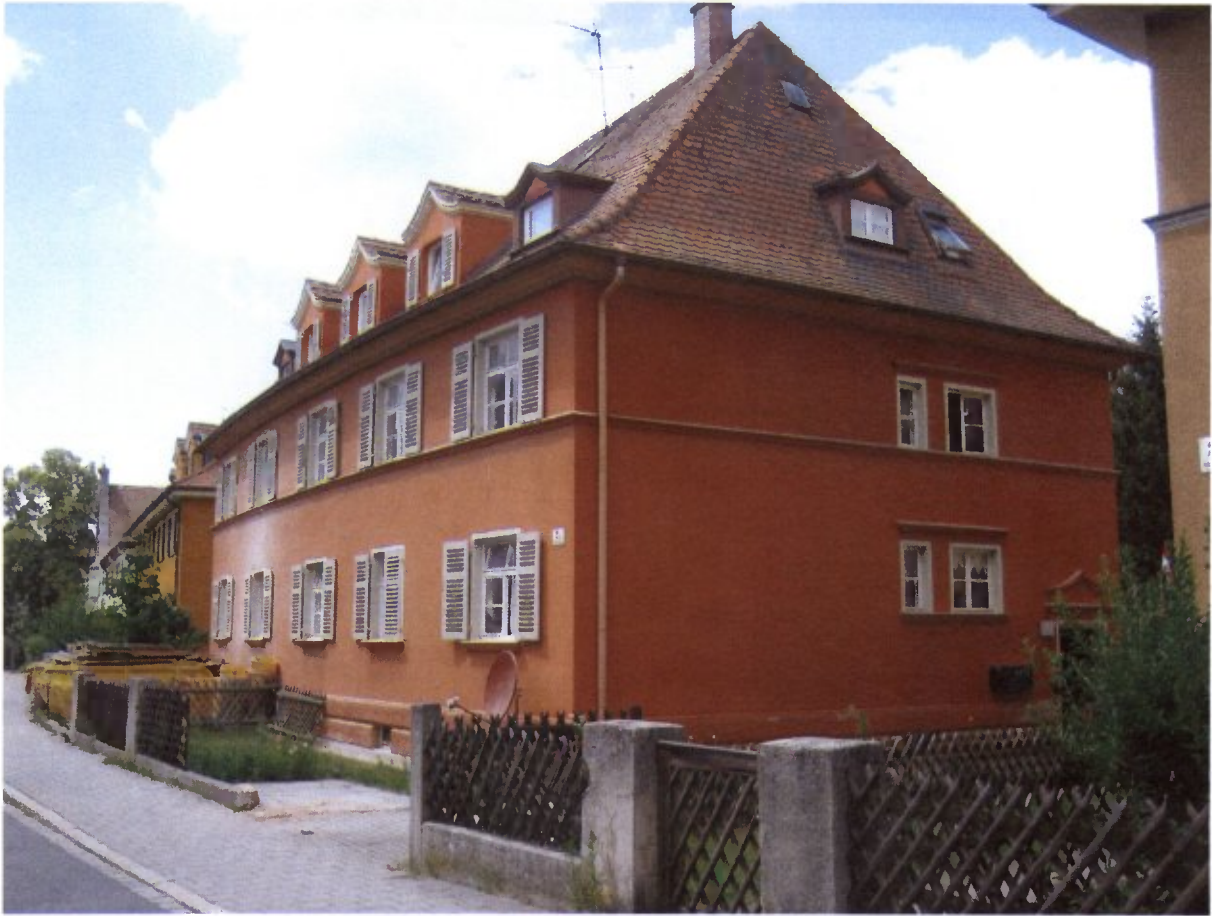
Reinhardstraße 2a, vor Maßnahmenbeginn
