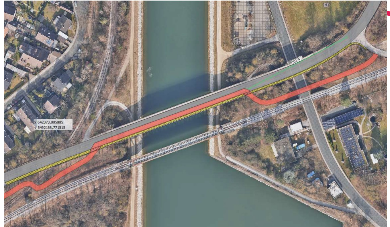
Nutzung bestehende Brücke mittels Engstellensignalisierung
