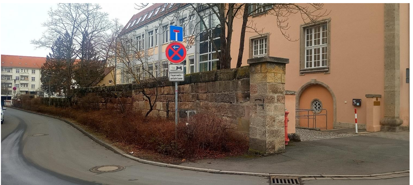
Fotoaufnahme Blickrichtung Norden
