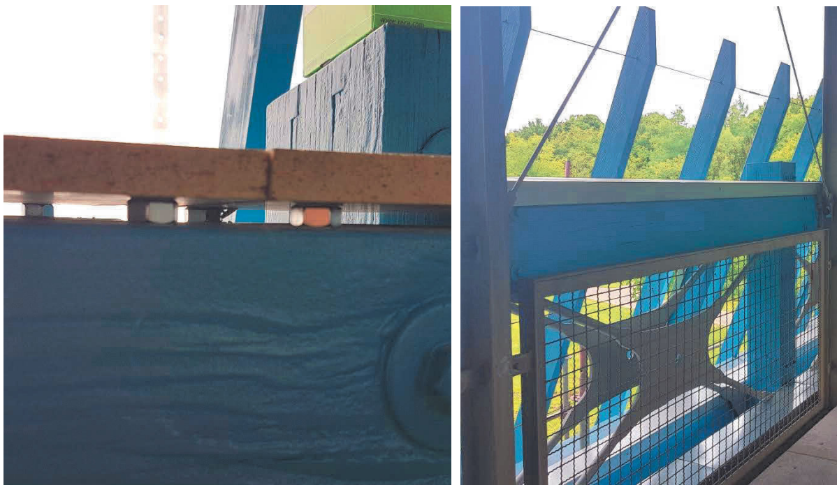
Abbildung 7 Hinterlüftete, zementgebundene Faserplatte und rechts fertige Blechabdeckung
