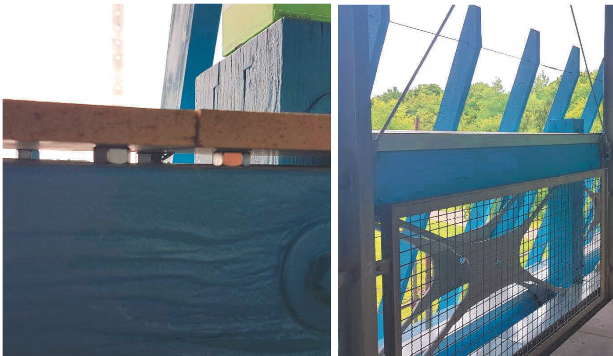
Abbildung 7 Hinterlüftete, zementgebundene Faserplatte und rechts fertige Blechabdeckung
