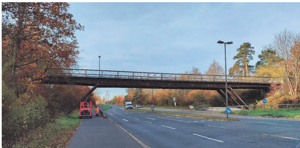
Abbildung 1: Ostansicht der Brücke
