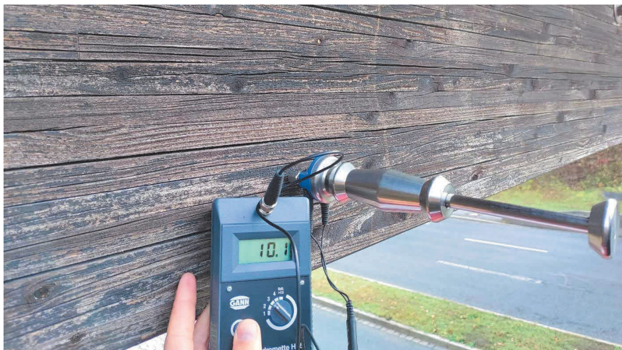
Abbildung 4 beispielhafte Abbildung einer Holzfeuchtemessung am Hauptträger
