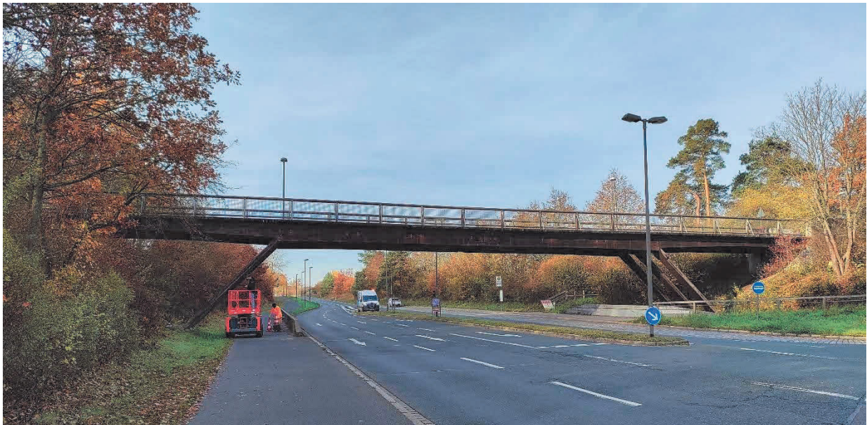
Abbildung 1: Ostansicht der Brücke
