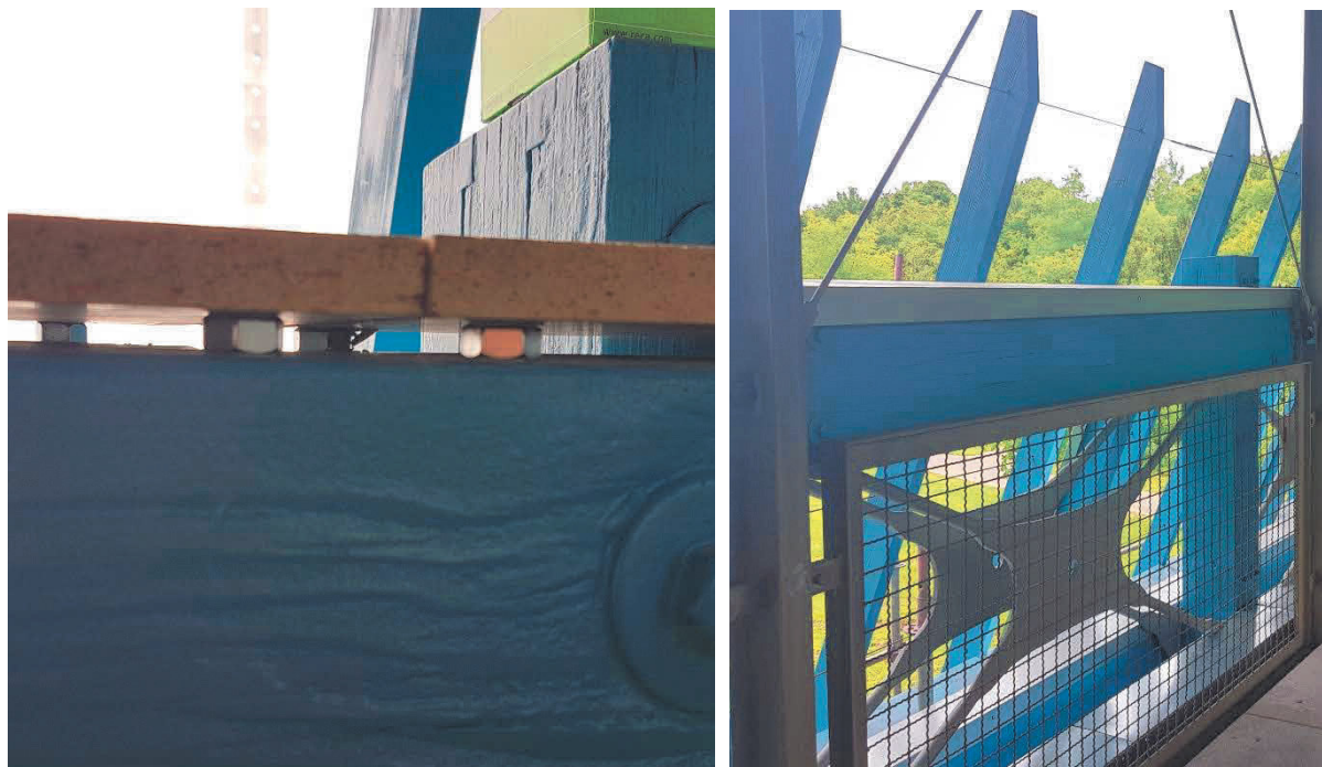
Abbildung 7 Hinterlüftete, zementgebundene Faserplatte und rechts fertige Blechabdeckung
