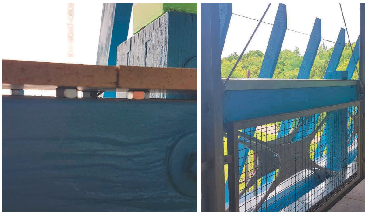
Abbildung 7 Hinterlüftete, zementgebundene Faserplatte und rechts fertige Blechabdeckung
