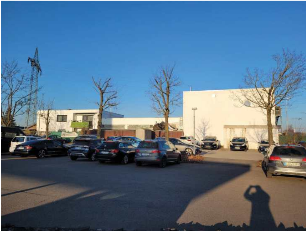
Autohaus Porisch Ostfassade
