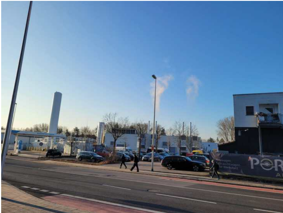
Zukünftige Einfahrt Feuerwehrgerätehaus
