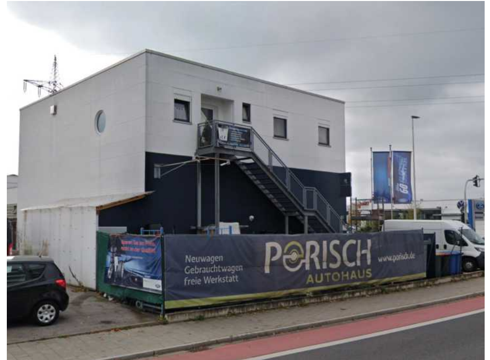
Autohaus Porisch Nordfassade
