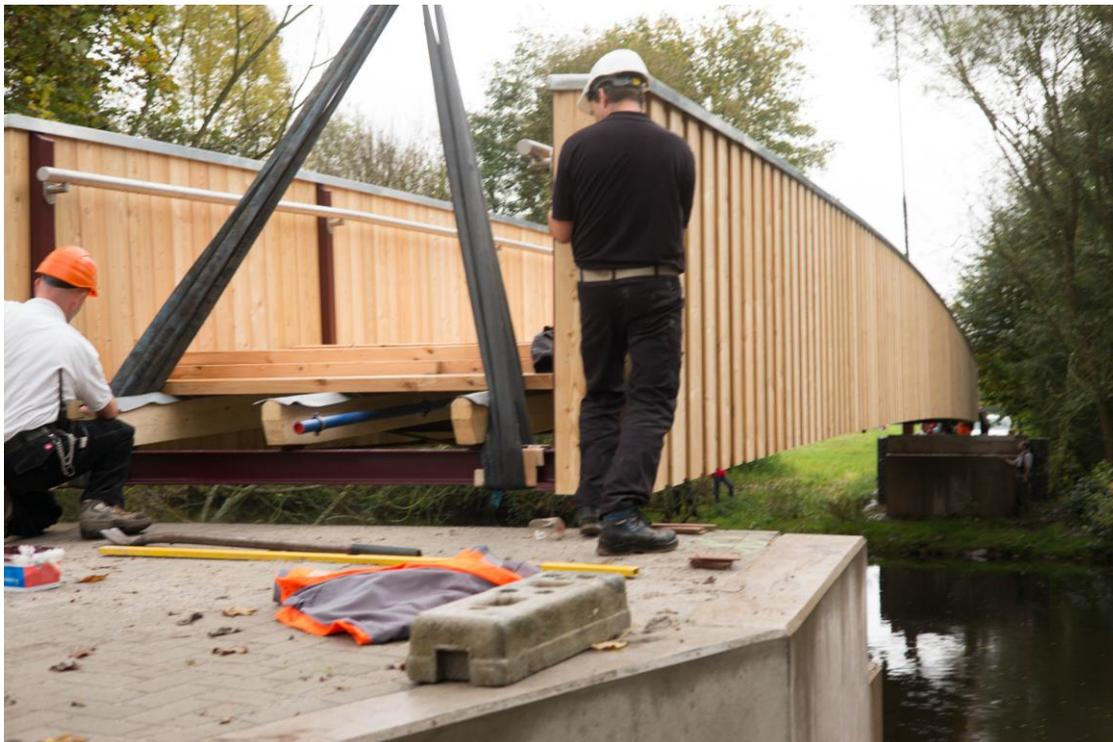
Bild 18, Transport/Einhub eines vorgefertigten 35 m Elementes für die Brücke, 66839 Schmelz Quelle: Fa. STRAB
