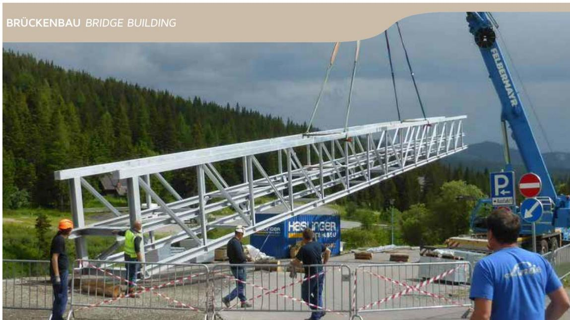
Bild 20, Einhub der Stahl-Fachwerkbrücke Lachtal, Quelle: Fa. Haslinger
