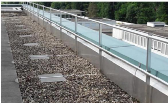
Abb. 24 Ausstattungsklasse 3: Seitenschutzsystem mit Auflast bodeneben montiert
