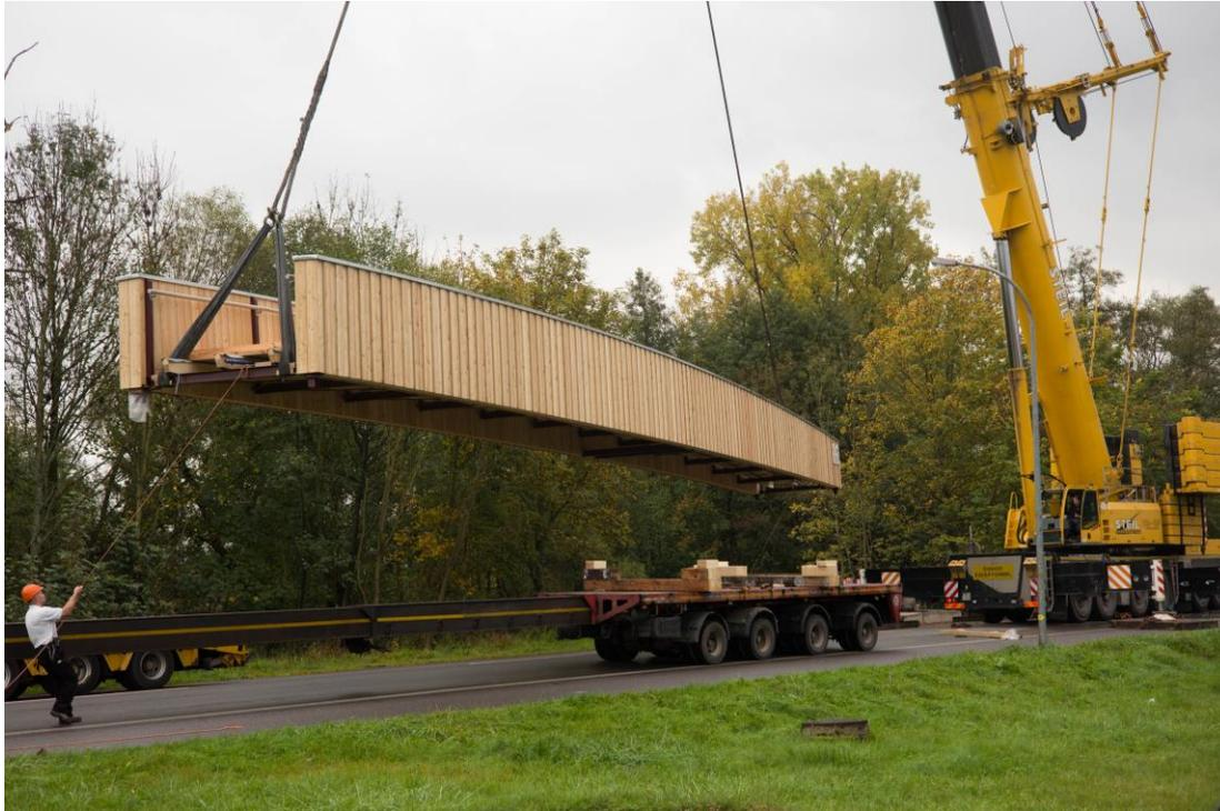
Bild 17, Transport/Einhub eines vorgefertigten 35 m Elementes für die Brücke, 66839 Schmelz Quelle: Fa. STRAB
