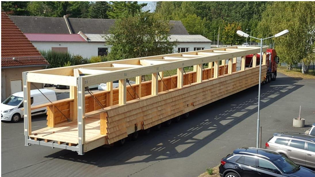
Bild 14, Transport eines vorgefertigten 34 m Elementes für die Brücke über die Kinzig Quelle: Fa. STRAB
