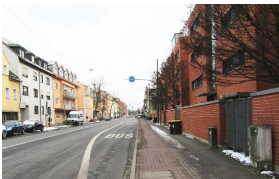
Foto: Haltestelle Hartmannstraße, ehemals Großpflaster, Sanierung 2022 erfolgt
