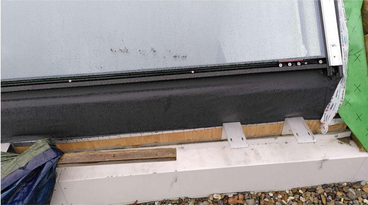
Detail Oberlichter: Mangelhafte Abdichtungsanschlüsse im Sockelbereich, daher Durchfeuchtung der dahinterliegenden Ebenen
