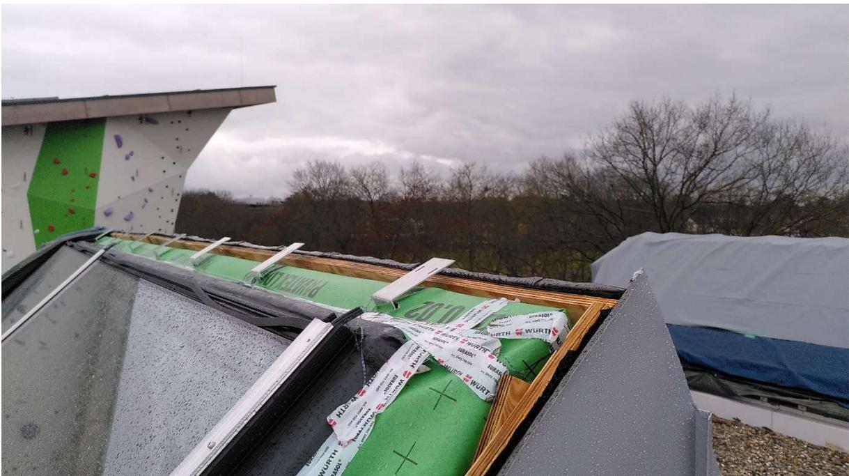
Detail Oberlichter: Mangelhafte und provisorische Abdichtungsanschlüsse mit fehlerhafter Durchdringung von Haltekonstruktionen
