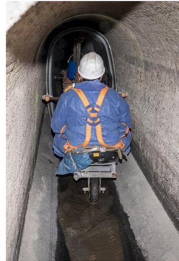
Abbildung 3: Beispiel Sanierung mit GFK-Rohren
