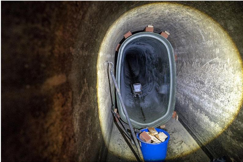
Abbildung 2: Beispiel Sanierung mit GFK-Rohren
