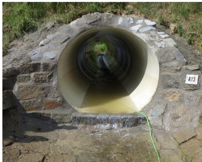
Abbildung 5: Beispiel Sanierung mit Wickelrohr nach Fertigstellung
