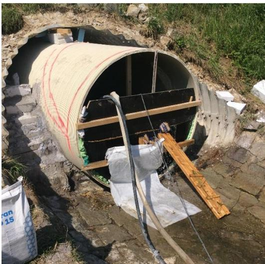
Abbildung 4: Beispiel Sanierung mit Wickelrohr
