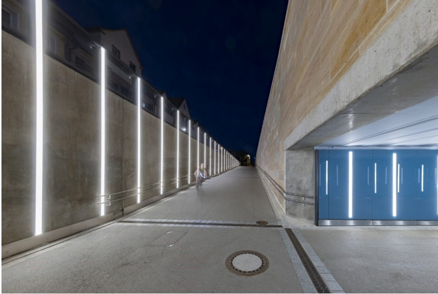
Rampe zum Gerbereitunnel mit Lichtlinien an der Stützmauer
