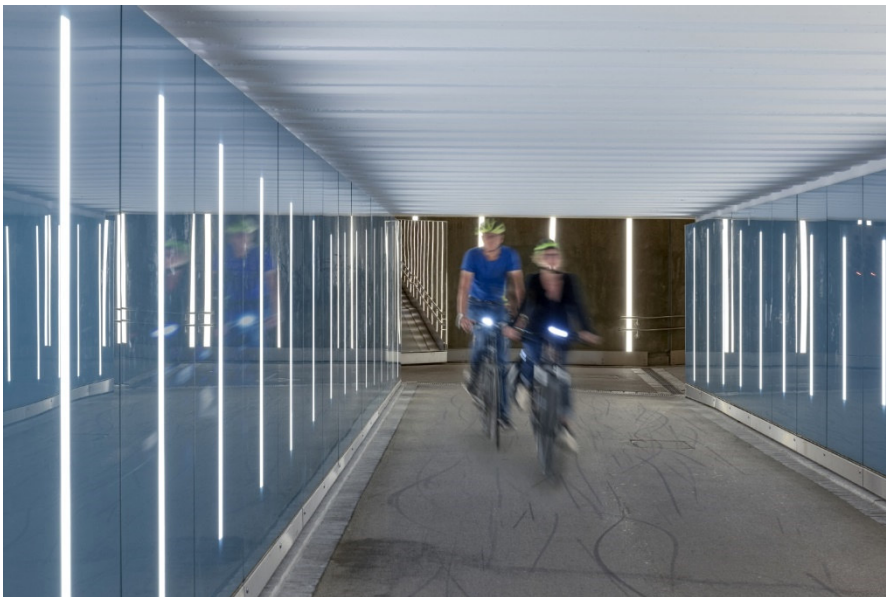
Tunneldurchgang mit Glaspaneelen
