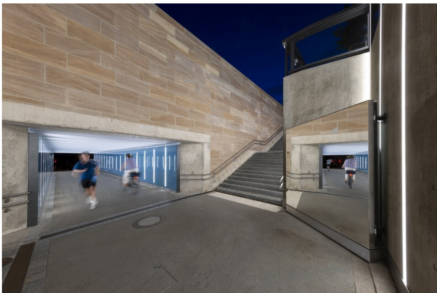
Zugang zur Unterführung mit Spiegel
