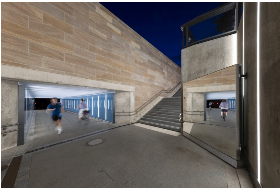
Zugang zur Unterführung mit Spiegel
