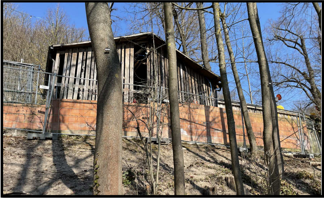
Anlage 7: Erneuerung der Böschungsmauer im Bereich Entlas Keller
