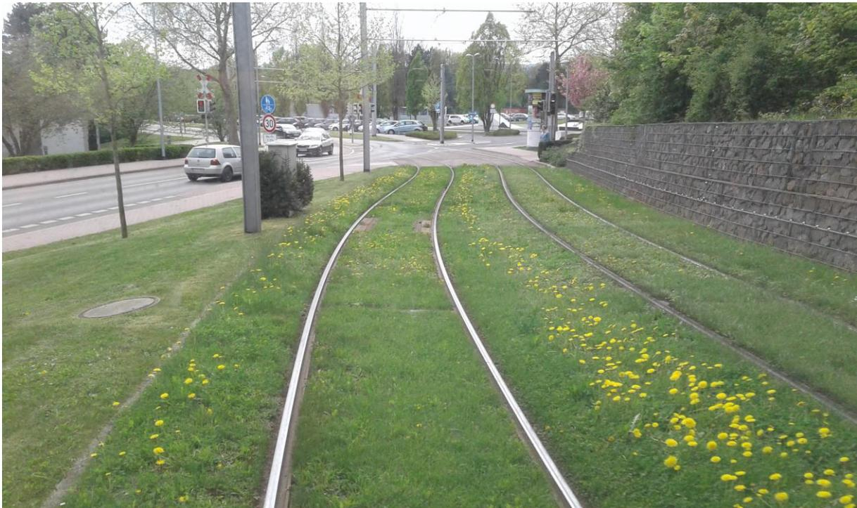
Abbildung 7: Beispiel Rasengleis in Seitenlage, Kassel, Foto: ZV StUB / Florian Gräf
