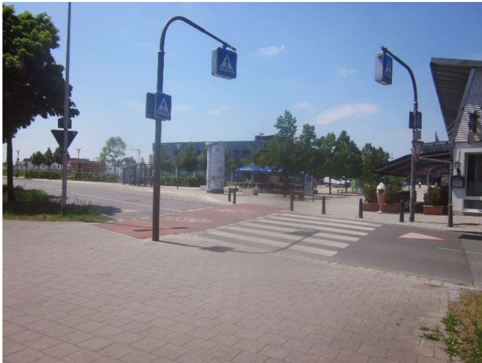
Beispiel für den Einsatz der Erlanger Standardlösung zur Bevorrechtigung des Rad- und Fußverkehrs in der Mönaustraße
