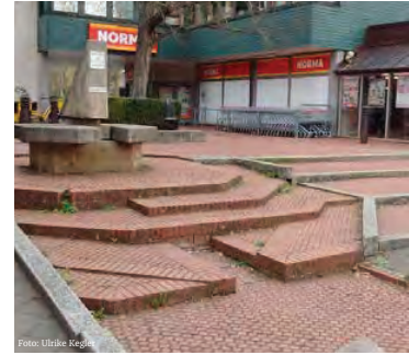
Büchenbacher Anlage Eingangsbereich NORMA mit Brunnen
