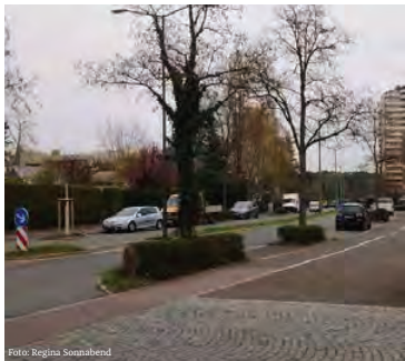
Umbau Steigerwaldallee für Parken und Bauminseln
