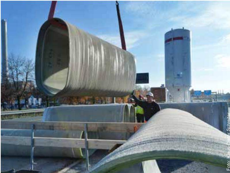
▲ Einheben der neuen Rohre in die Baugrube
