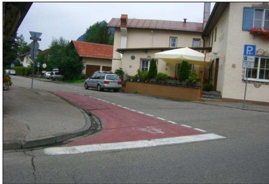
Abb. 14 Ausfahrtpforte für den gegen gerichteten Radverkehr (Sonthofen)
