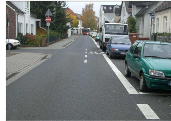
Abb. 11 Einbahnstraße (3,50 m Fahrgasse) mit Busverkehr und gegen gerichtetem Radverkehr. An zahlreichen Hausgrundstückszufahrten bestehen Ausweichmöglichkeiten (Verden)
