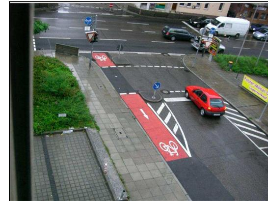
Abb. 15 Baulich geschützter Einfahrtbereich an einem LSA-Knoten (Stuttgart)
