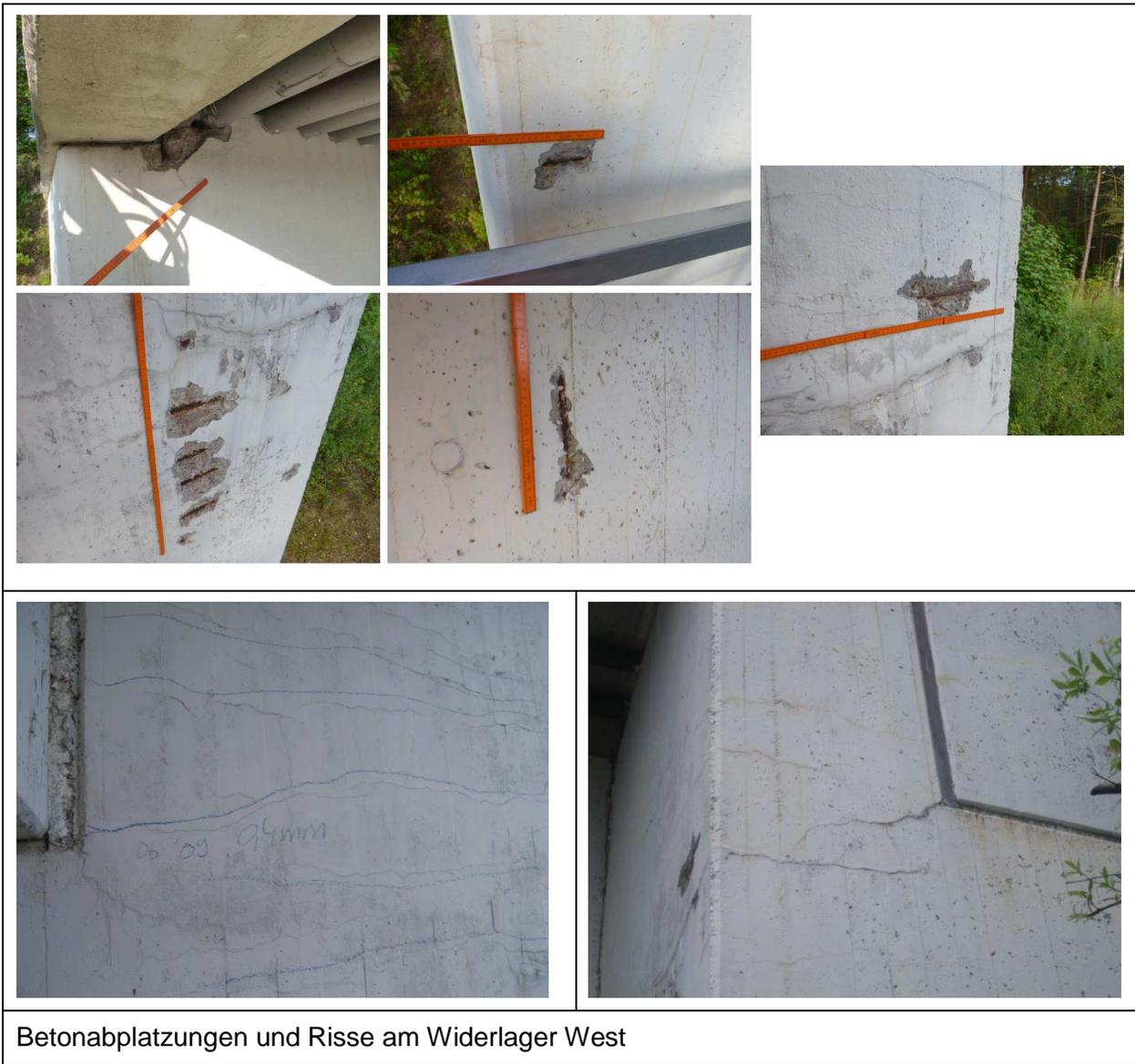
Betonabplatzungen und Risse am Widerlager West
