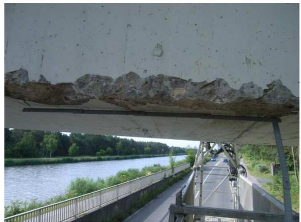
Betonschäden und -risse an Brückenüberbau
