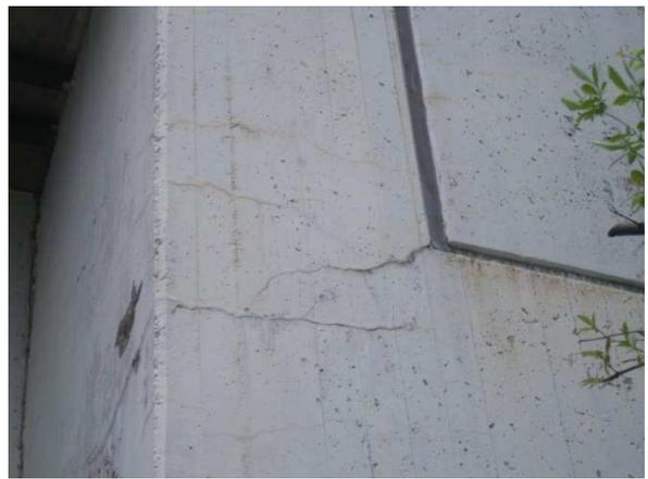
Betonabplatzungen und Risse am Widerlager West
