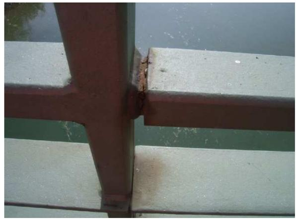
Geländer mit abplatzender Beschichtung, Roststellen und Durchrostungen, mangelhafter Einbindung
