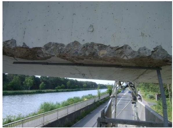
Betonschäden und -risse an Brückenüberbau
