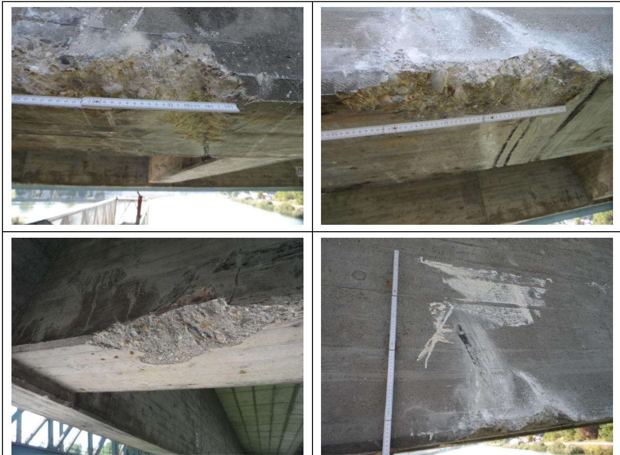
Betonschäden an der Untersicht der Straßenbrücke
