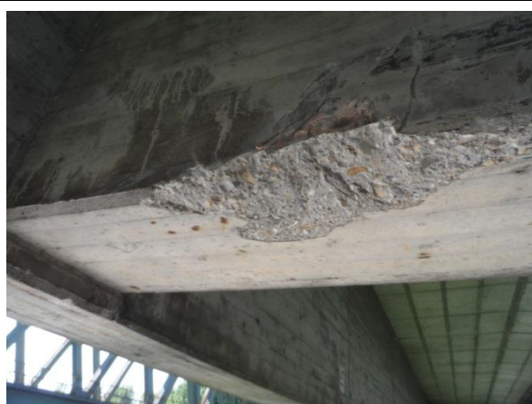
Betonschäden an der Untersicht der Straßenbrücke
