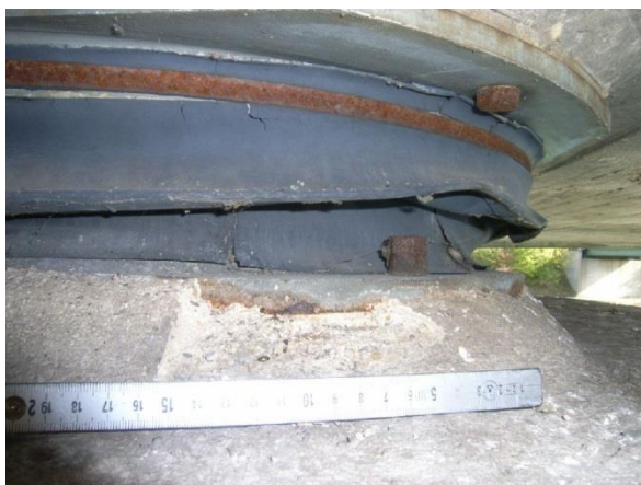
Taubenkot, -ablagerungen, nicht ausreichende Taubenvergrämungsanlage
