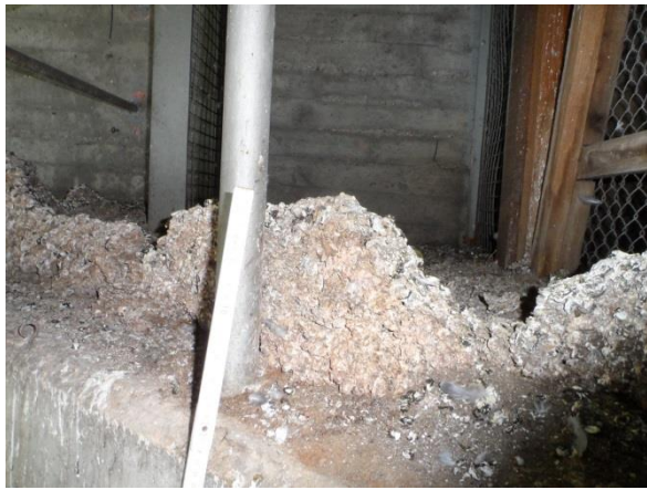
Taubenkot, -ablagerungen, nicht ausreichende Taubenvergrämungsanlage
