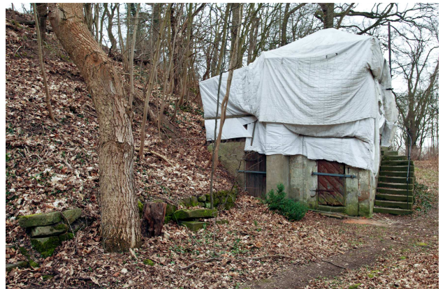
Abb. 10: Gartenhaus im Schunckschen Garten; Zugang zu Kellergeschoss und Treppenaufgang; Nordansicht
