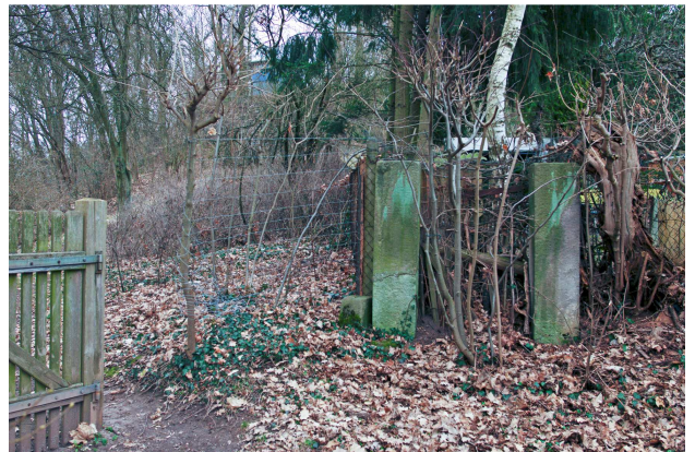
Abb. 18: Ehemaliges Gartentor an der nordöstlichen Gartengrenze, Torpfeiler aus Sandstein
