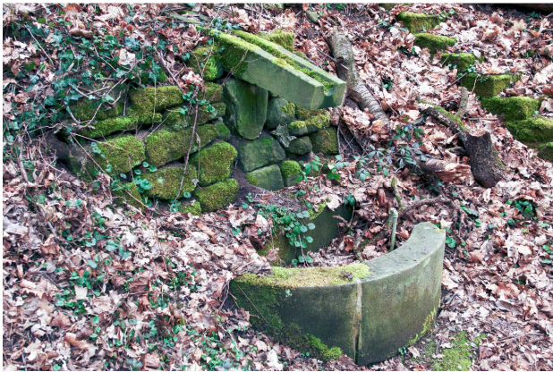
Abb. 15: Brunnenbecken mit überkragendem Zu- lauf, Sandstein; innerhalb der Treppenanlage
