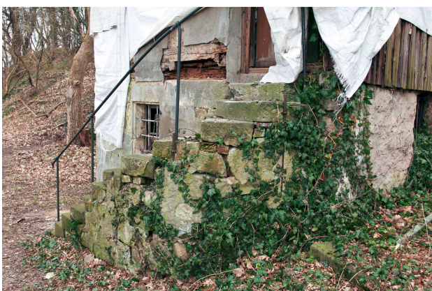
Abb. 11: Treppenaufgang zum Obergeschoss des Schunckschen Gartenhauses; Südwestansicht
