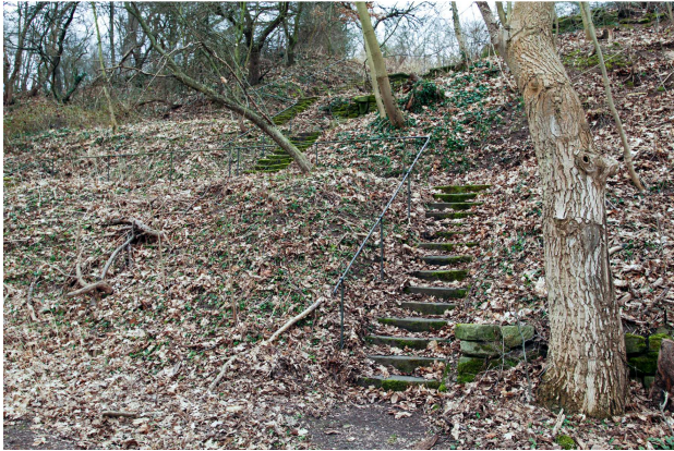
Abb. 13: Treppenanlage im Schunckschen Garten; Sandstein-Blockstufen mit Metallhandlauf
