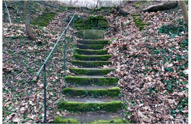
Abb. 14: Treppenläufe in den westlich abfallenden Terrassenböschungen
