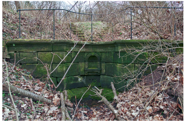
Abb. 16: Hangmauer mit profilierten Abdeckstei- nen und eingelassener Nische, Sandstein
