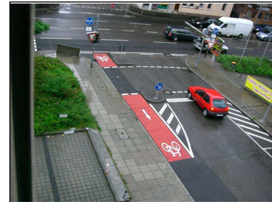
Abb. 15 Baulich geschützter Einfahrtbereich an einem LSA-Knoten (Stuttgart)
