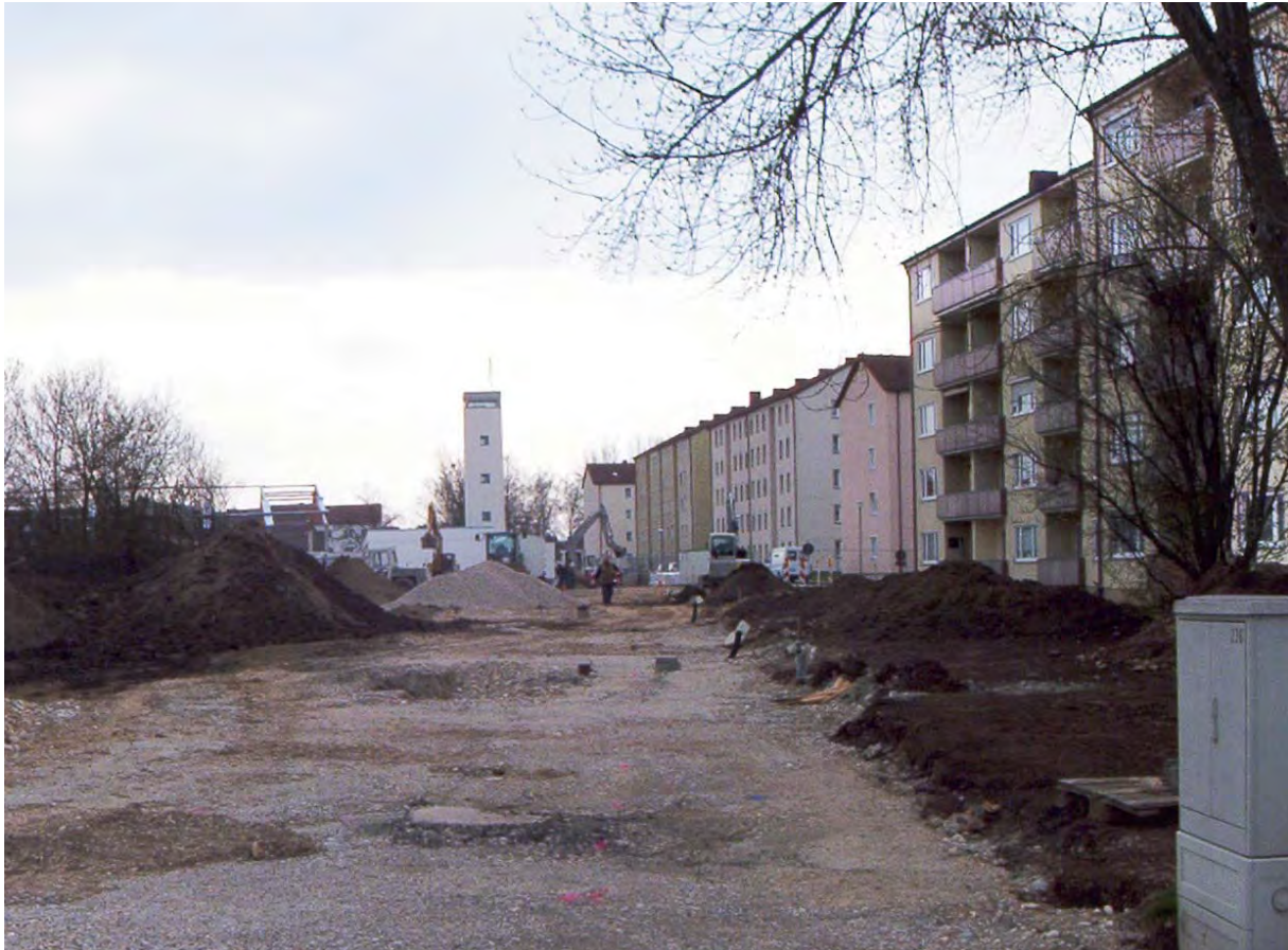
Vorher - Verkehrsstraße (hier: Abrissarbeiten)
