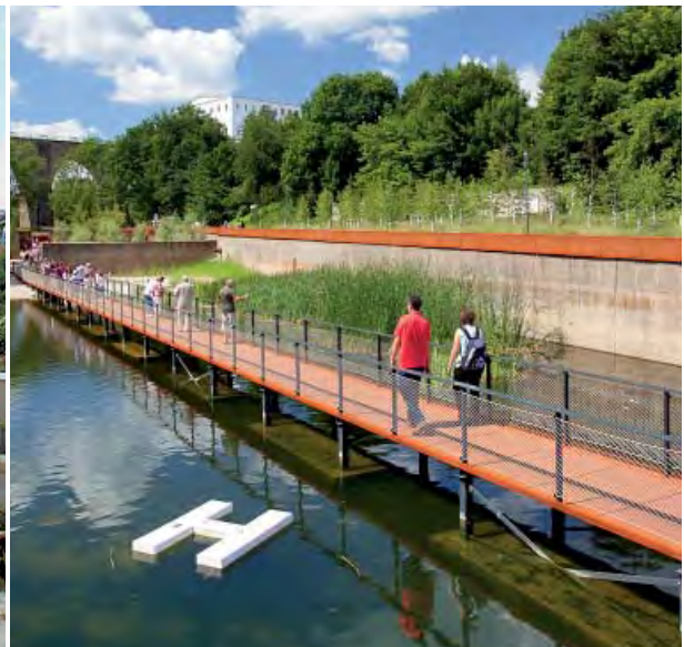
Nachher - begehbare Wasserbecken
