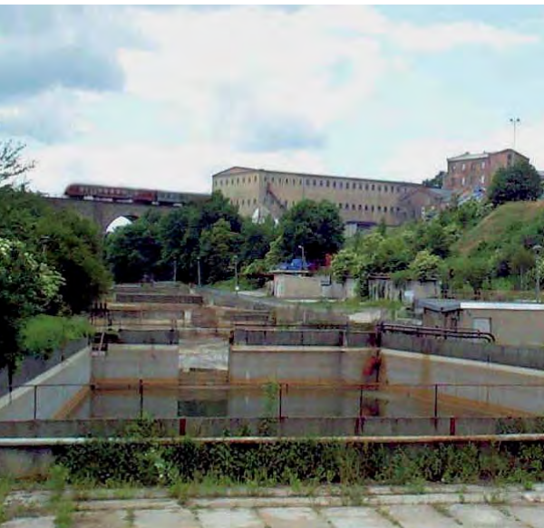
Vorher - ehemaliges Absetzbecken
