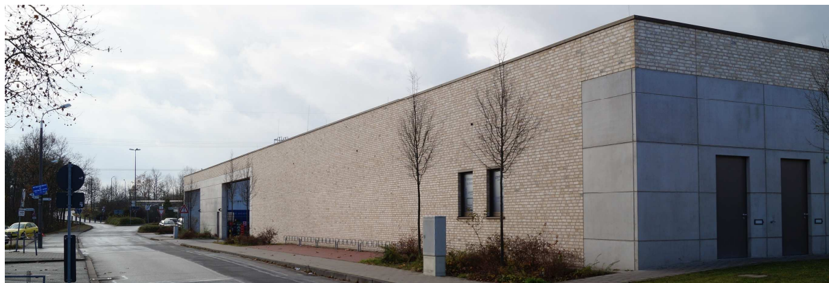
Nahversorgungszentrum (Rückseite) gegenüberliegende Straßenseite
