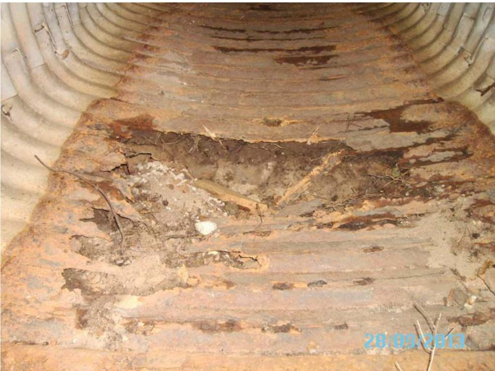
Sohle der Wandung Wellstahlprofil durchgerostet, Lochfraß. Gefahr der Ausspülung und daraus möglich folgender Straßeneinbruch. Durchlassüberdeckung nur 17 cm bis Straßenoberkante.
