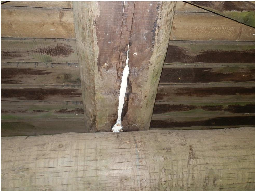
Pilzbefall des Längsträgers auf einer Länge von ca. 4,0 m
