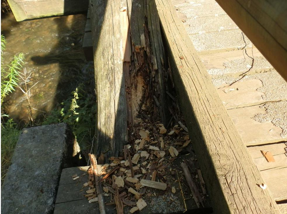
Im hinteren Bereich der Schrägstrebe des Knotens ist der unterstromigen Längsträger beim Widerlager zu ca. 70 % des Querschnitts auf 1 m Länge verfault.  $S/V/D = 3/0/3$
