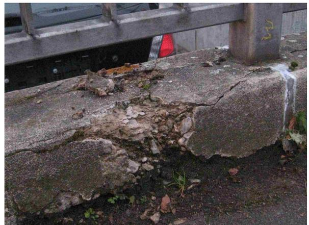
Stützwand massiv, ausgeprägt gerissen (Rissbreiten bis 4 mm), mit Aussinterungen, zerfallendes Betongefüge, Füllstabgeländer stark rostend, Pfostenverankerung herausgebrochen
