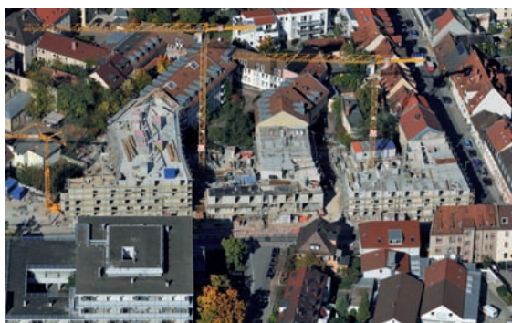
Abb. 39: Beispiel Entwicklung einzelner Baugrundstücke Studentenapartments in der Henkestraße
