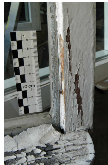
Detailaufnahmen der maroden Stock- und Flügelrahmen historischer Fenster
