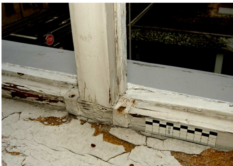
Detailaufnahmen der maroden Stock- und Flügelrahmen historischer Fenster
