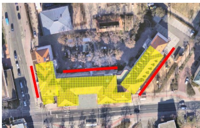
Abb. 4: Umfang der Fassaden- und Dachsanierung
