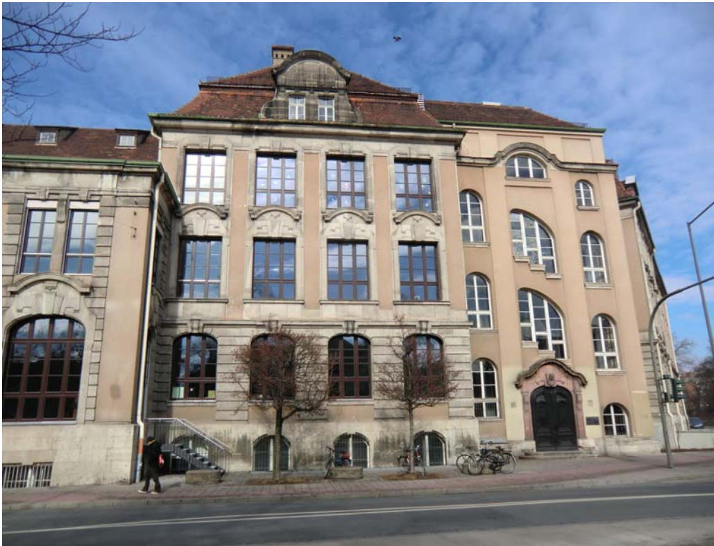
Abb. 1: Südfassade entlang Henkestraße
