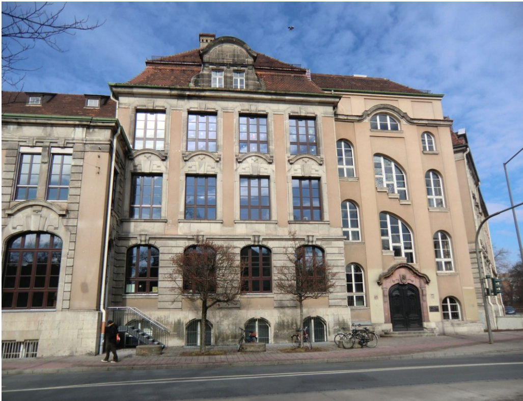
Abb. 1: Südfassade entlang Henkestraße
