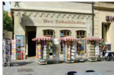
- Unmengen an Warenständern verdecken die ansprechende Fassade
