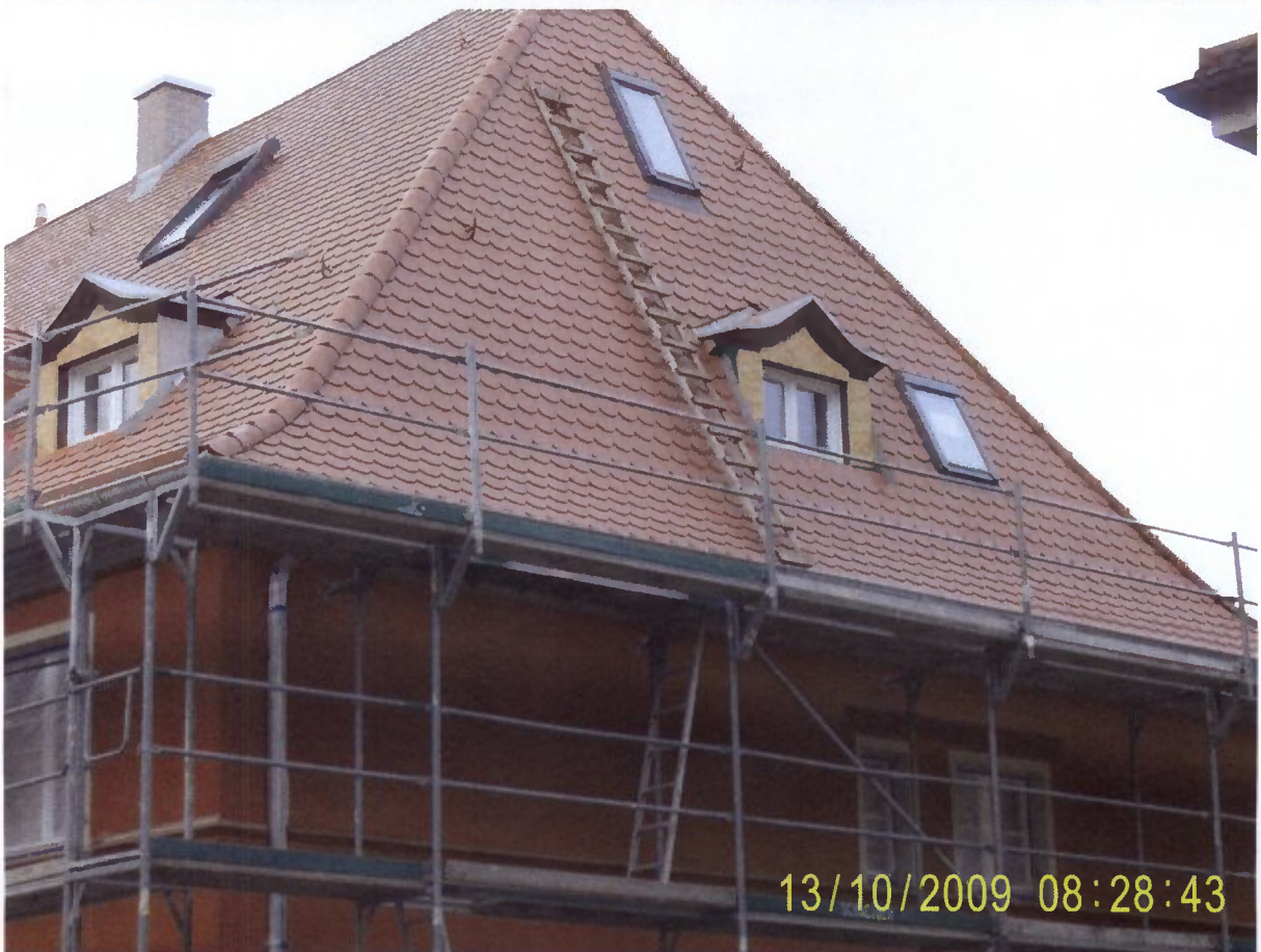
Reinhardstraße 2a, während der Baumaßnahme
