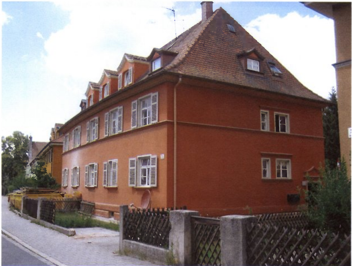
Reinhardstraße 2a, vor Maßnahmenbeginn
