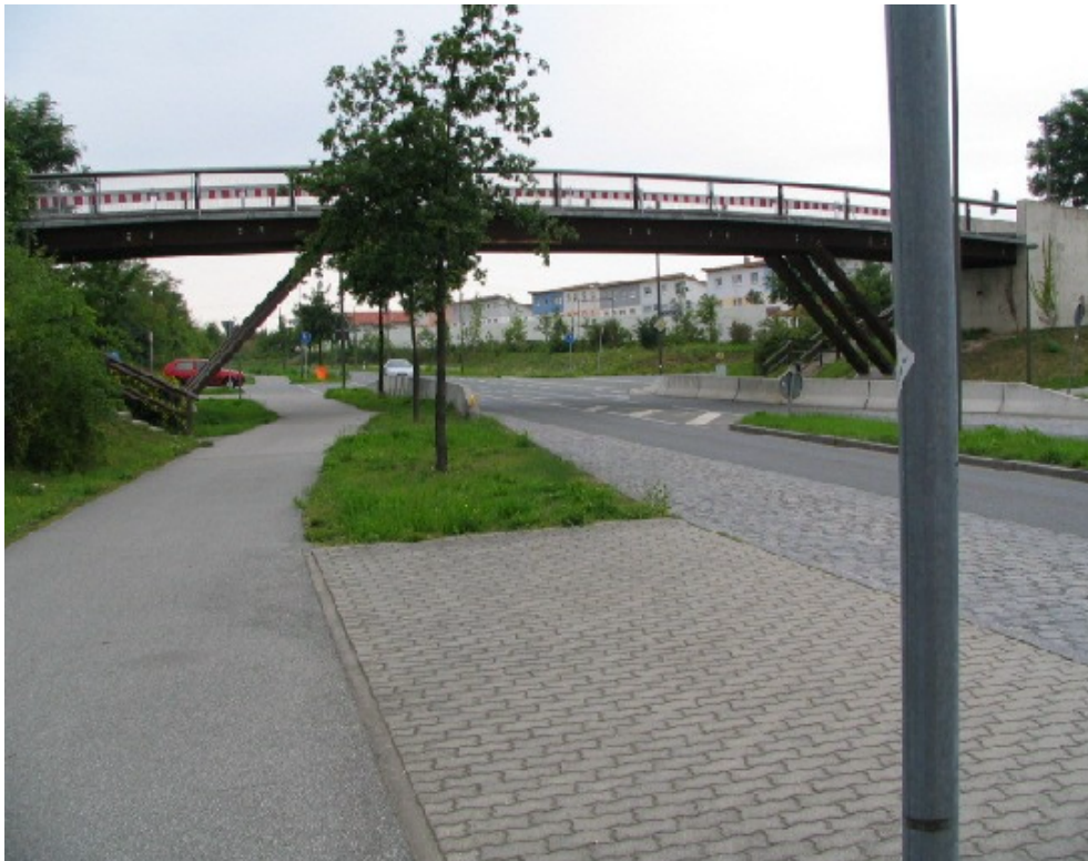
Fuß- und Radwegbrücke über den Adenauerring Nord am Westerwaldweg in Büchenbach
